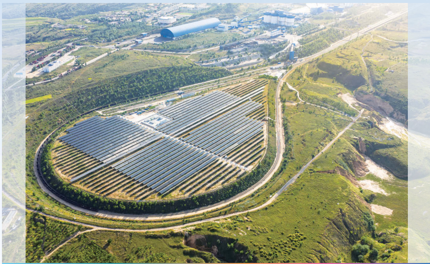
• 华电煤业 + 不连沟煤矿分布式光伏电站
