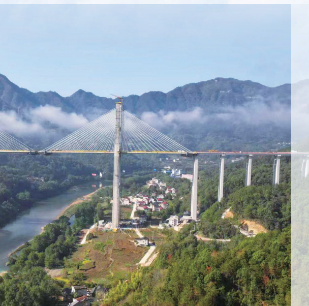
• 炉慈高速长潭河溇水特大桥
