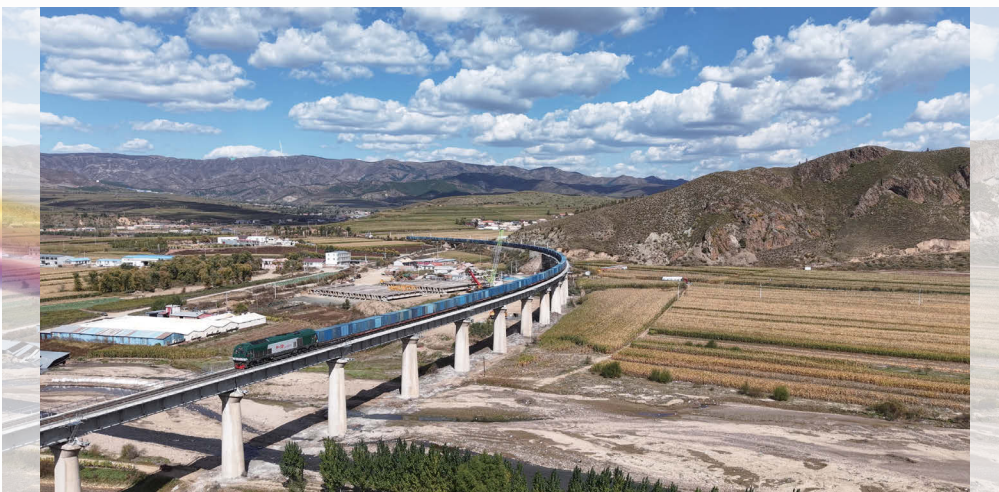
· 京通铁路换梁改造工程
